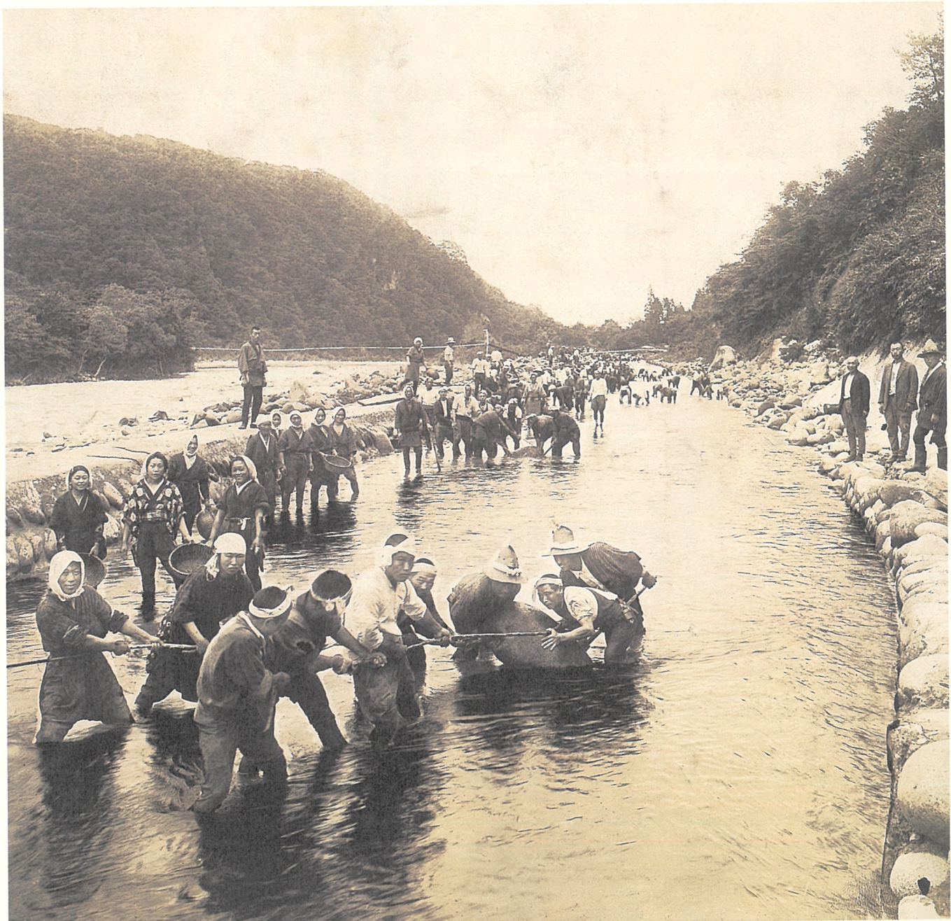
昭和14年当時の「川普請」(石や砂をさらって水を流れやすくする)の様子。左側の石積みが「中凌ぎ」である。
