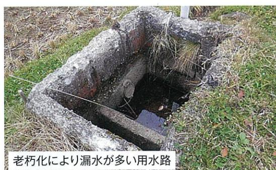
老朽化により漏水が多い用水路
