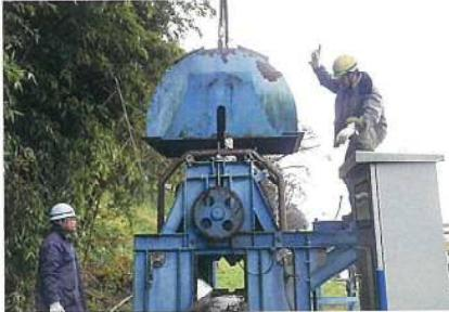
除塵機分解整備 工事施工中
