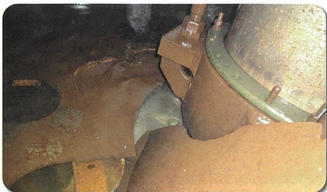
【破損状況】 減勢槽内部底板のめくれ
