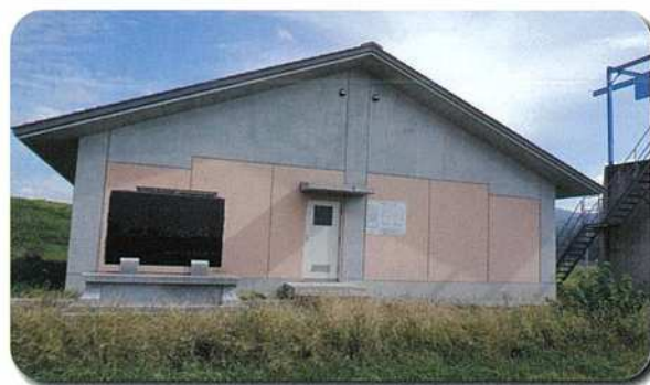
二渡揚水機場
