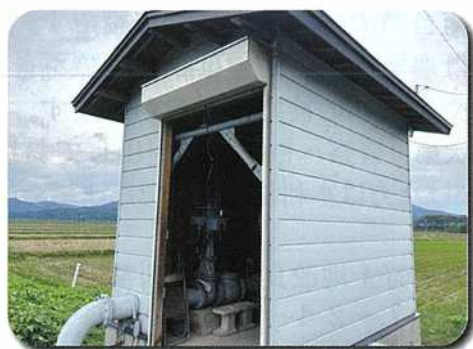
天王谷起揚水機場
