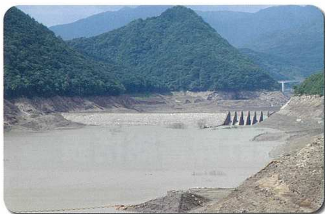
6年ぶりに姿を現した旧石淵ダム堤体
